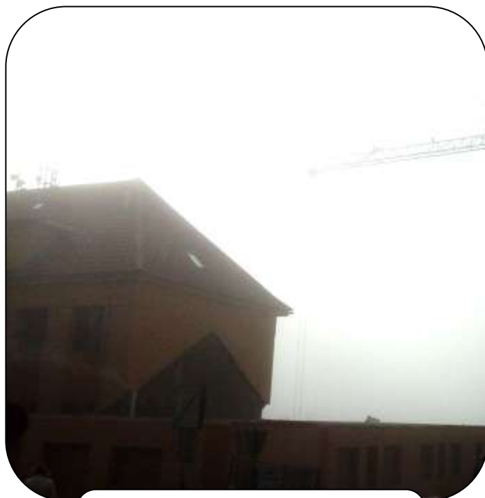
Střecha s podkrovím staré budovy musela uvolnit místo novým třídám, které budou ve vyšších patrech.
