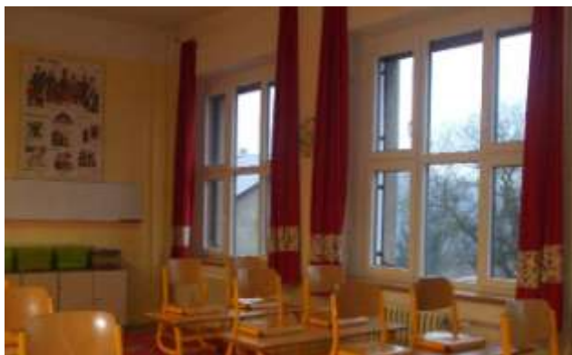
První třída po výměně i po úklidu.
